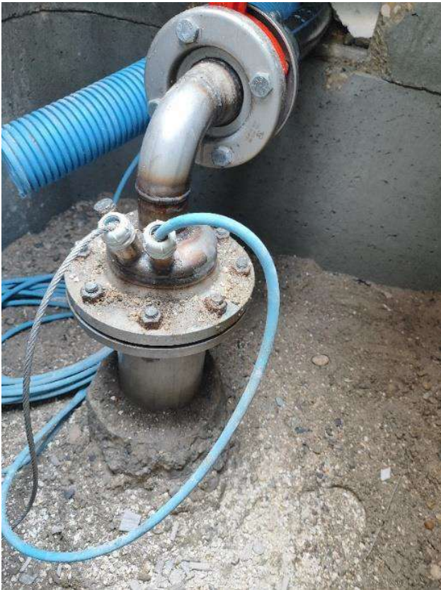
Illustration 5.7: Exemple de tête de forage étanche (photo Innovia)
